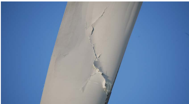
Gravierende Schäden mit SHM.Blade vermeiden
